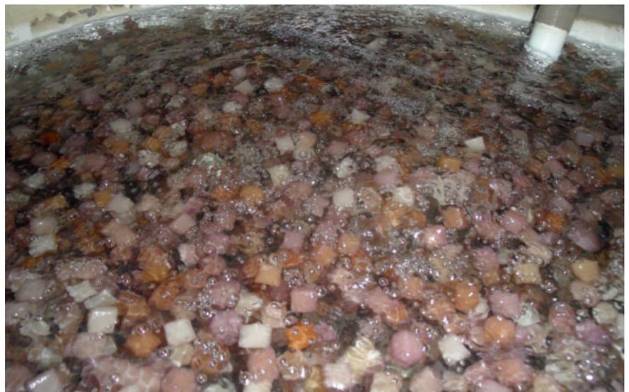
Abbildung 8: Blick in die biologische Grauwasseraufbereitungsstufe. Das Wirbelbett mit Schaumstoffwürfeln nach einer 15-jährigen Betriebszeit ohne Austausch der Reinigungskörper
