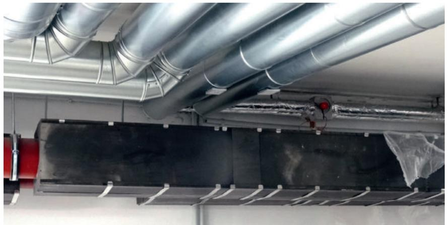
Abbildung 3: Außenansicht des gedämmten Rohrwärmetauschers AWT 2 als SML-Rohr mit ummanteltem Wärmetauscher
